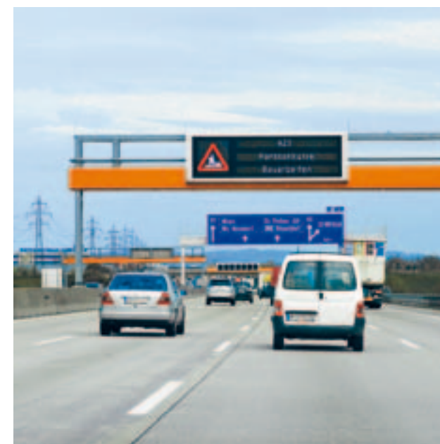
Vorankündigung Baustelle A 23 Hanssonkurve
